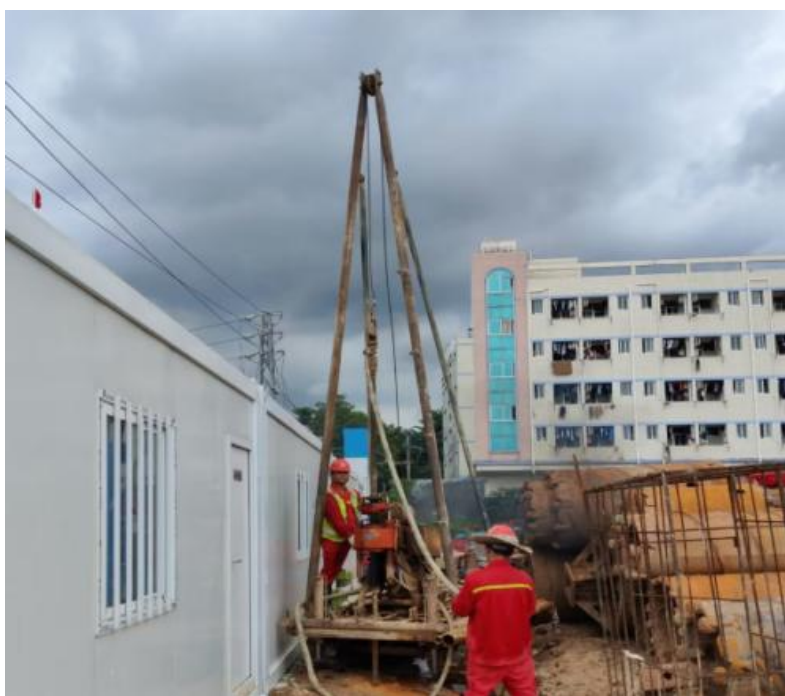
图 5.5-1 测斜监测点成孔埋设示意图
